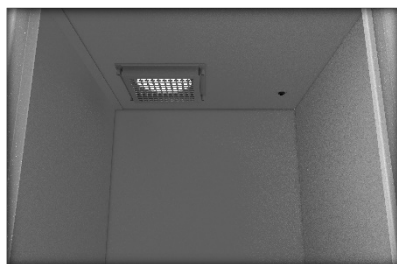
Anemostat z możliwością podpięcia do systemu wentylacji
